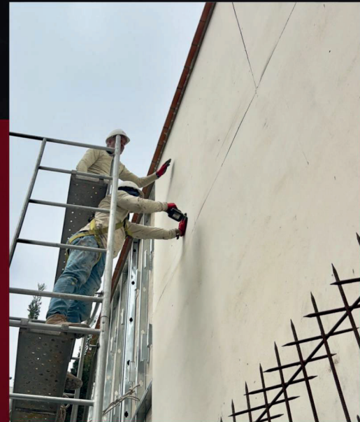
Instalación y reforzamiento de planchas de superboard
