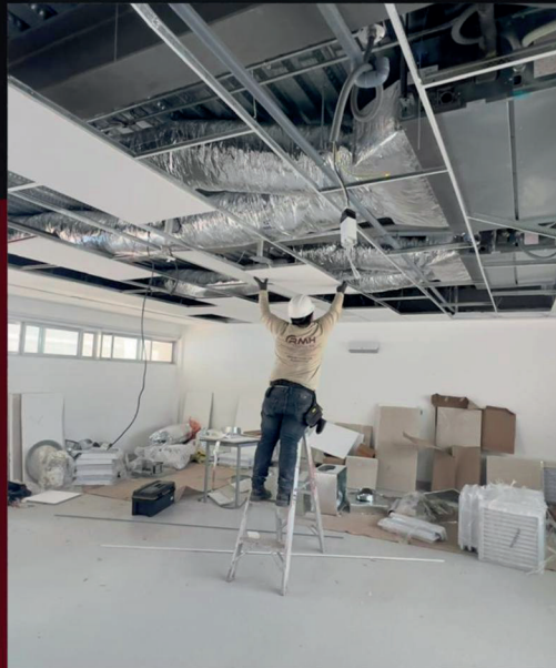
Instalación integral de cielo raso en aulas del 1er nivel - Pabellón J
