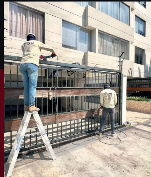
Lijado integral de estructuras metálicas
