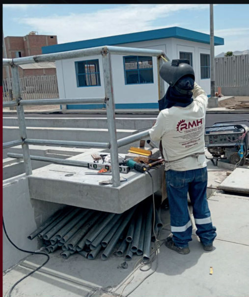
Soldadura integral en barandas metálicas
