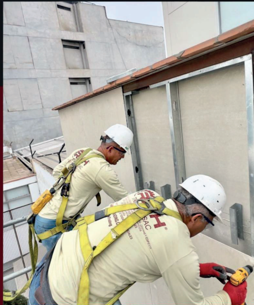
Instalación y reforzamiento de planchas de superboard
