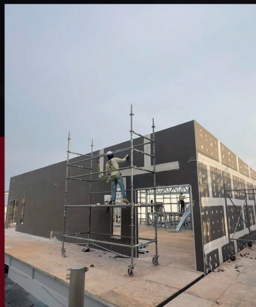
Cerramiento integral en aulas del 3er nivel - Pabellón J
