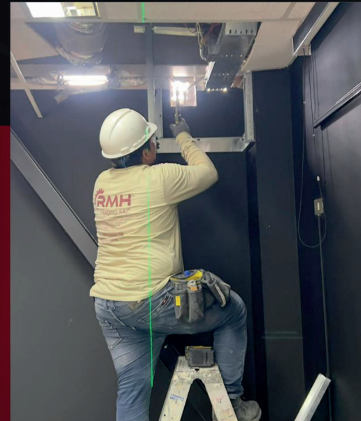
Fabricación e instalación integral de cenefas en aulas
