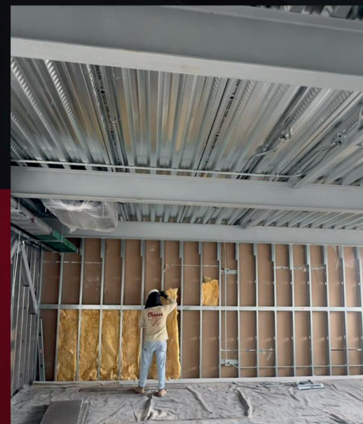
Instalación integral de perfilería galvanizada
