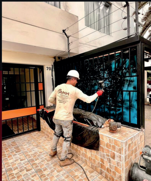
Pintado de estructuras metálicas en rejas
