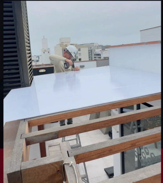
Suministro e instalación de techo de policarbonato
